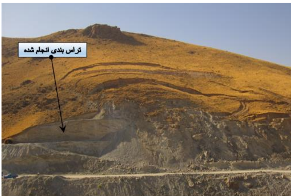
شکل ۲. وضعیت لغزش در شیروانی
