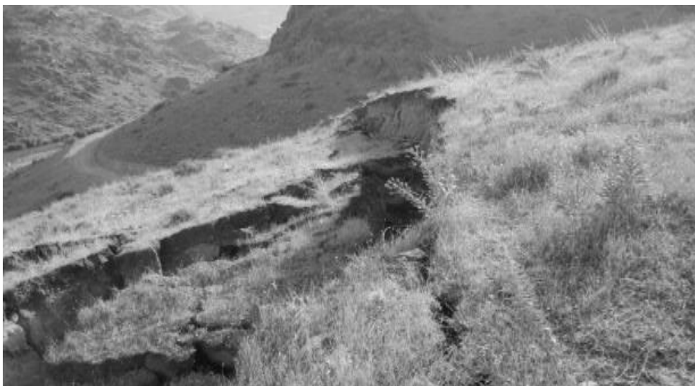
شکل ۱. وضعیت گسیختگی و سطح جدایش در تاج شیروانی
